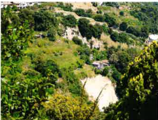
Photo 5 : Zone potentielle de départs de glissement : secteur Fabron
